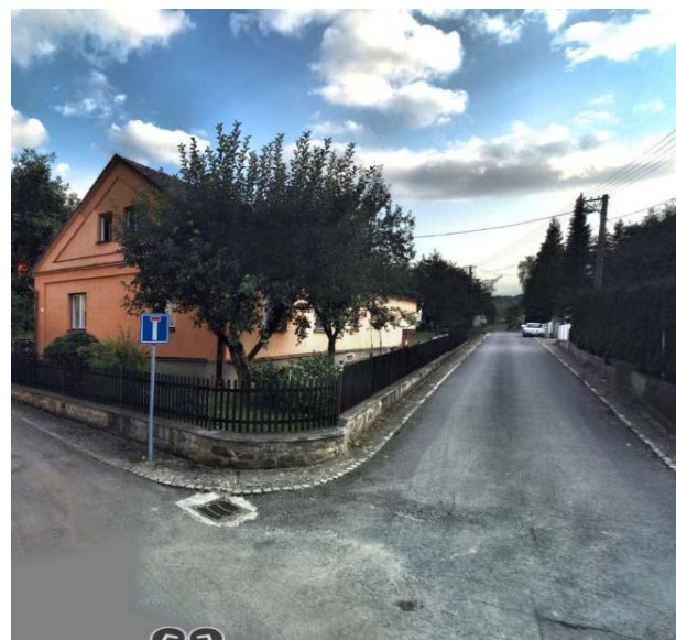
Místní komunikace, příjezd
