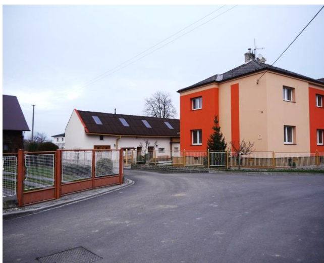
Ulice Komenského, v místě odbočení k trafostanici
