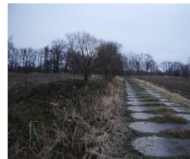
Odvodňovací příkop podél panelové cesty
