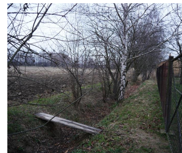
Příkop pro odvádění dešťových vod
