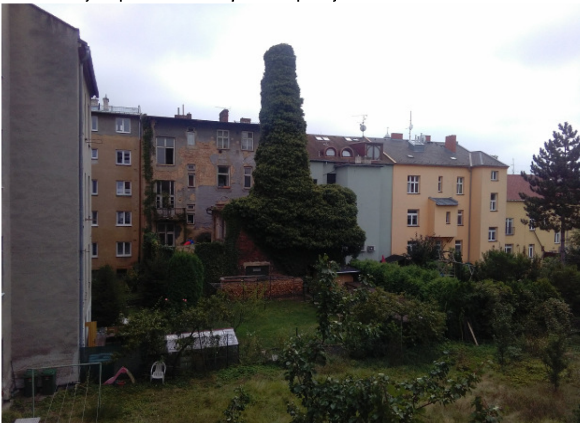
Obrázek 29: Bývalá pekárna a komín v jednom z opavských vnitrobloků
