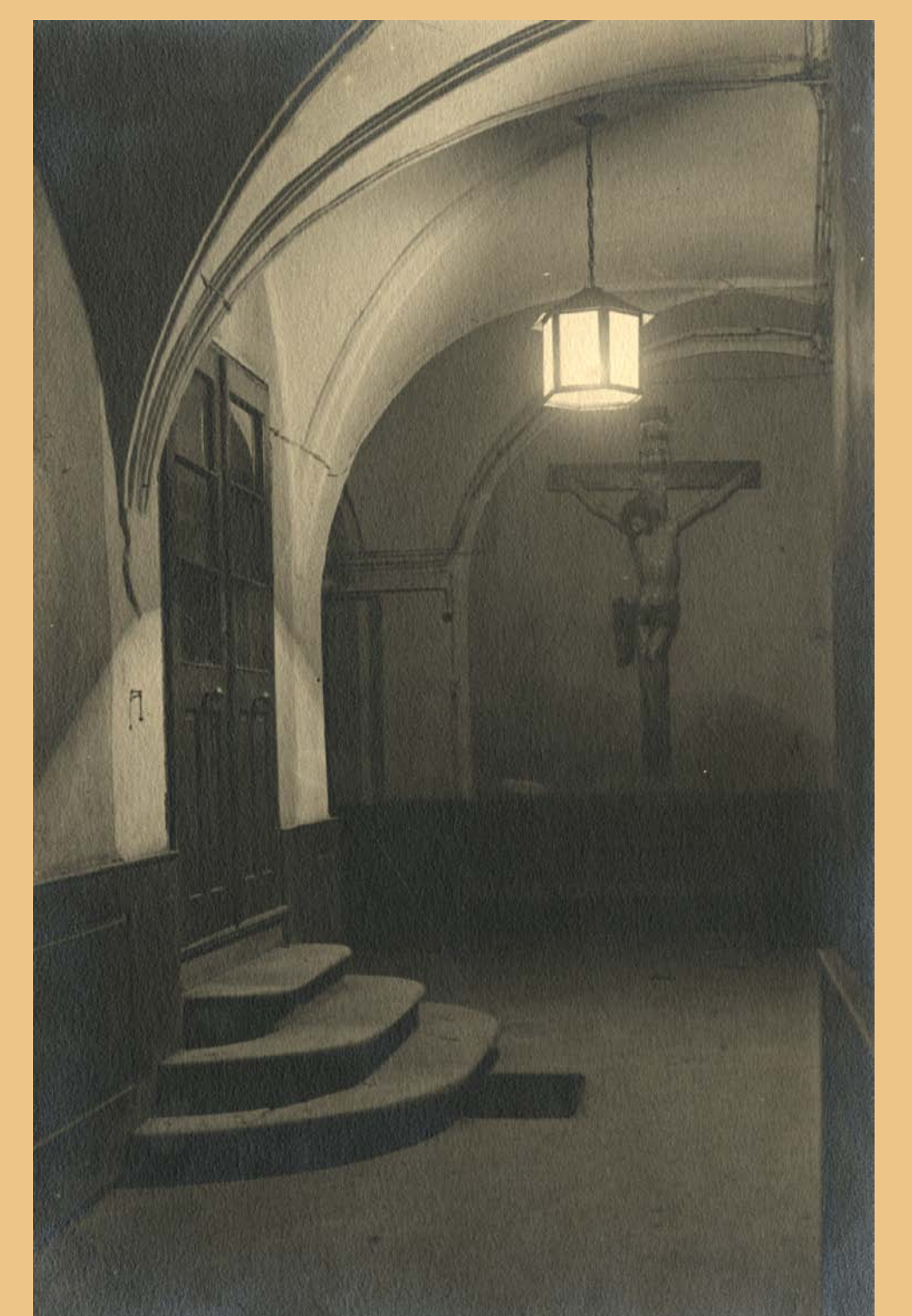
• V jižní části přízemí se nachází sň z poloviny 16. století klenutá renesanční valenou žebřikovou klenbou s výsečemi, která je charakteristická pro opavské renesanční domy. V 19. století provedená vestavba prodělní místnosti narušila dispozici a zničila část štukové dekorace. /Slezské zemské muzeum/
