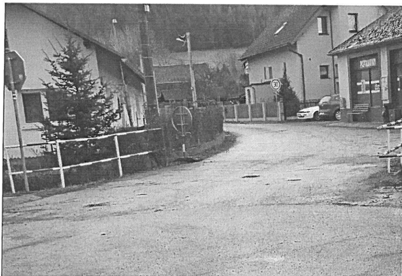
Pohled na most z komunikace III/10125 (ul. Hlavní) ze dne 14. 1. 2019
