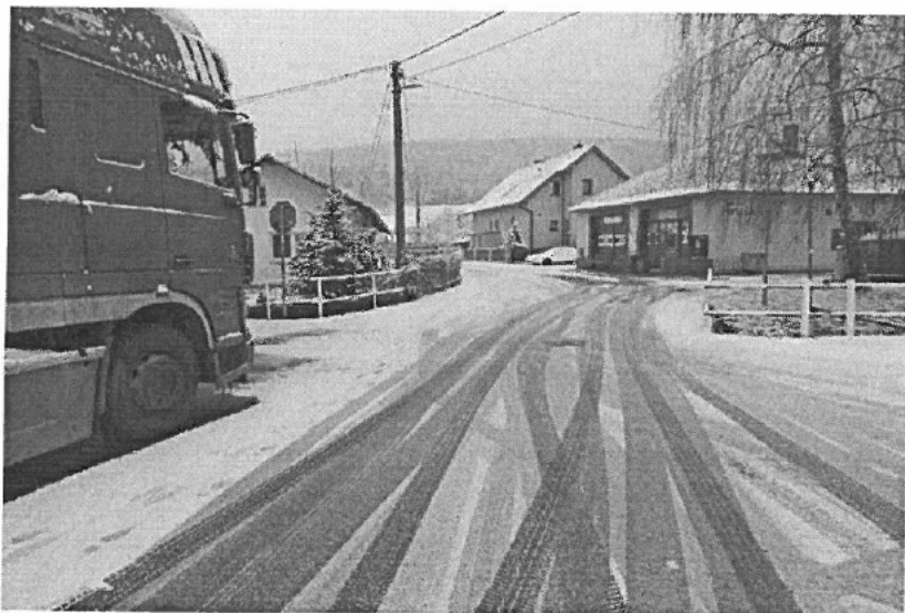
Pohled na most z komunikace III/10125 (ul. Hlavní) ze dne 10. 1. 2019
