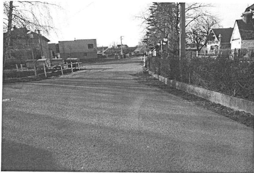
Pohled na most z komunikace U Hříště ze dne 17. 3. 2019
