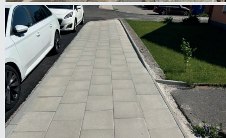
Chodník na ulici Mostní před a po rekonstrukci.
