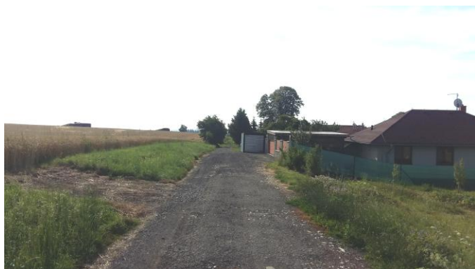
Stávající zpevněná část ul. Severní – západní část
