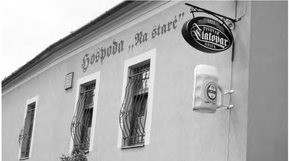
KOMÁROVSKÉ FOJTSTVÍ bylo údajně umístěno v dnešní budově hospody Na Staré. Foto Michal Novotný
